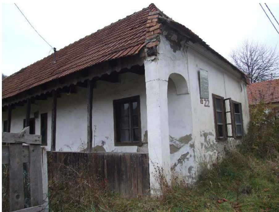
Tájház (veszélyeztetett) (Településképileg meghatározó)
