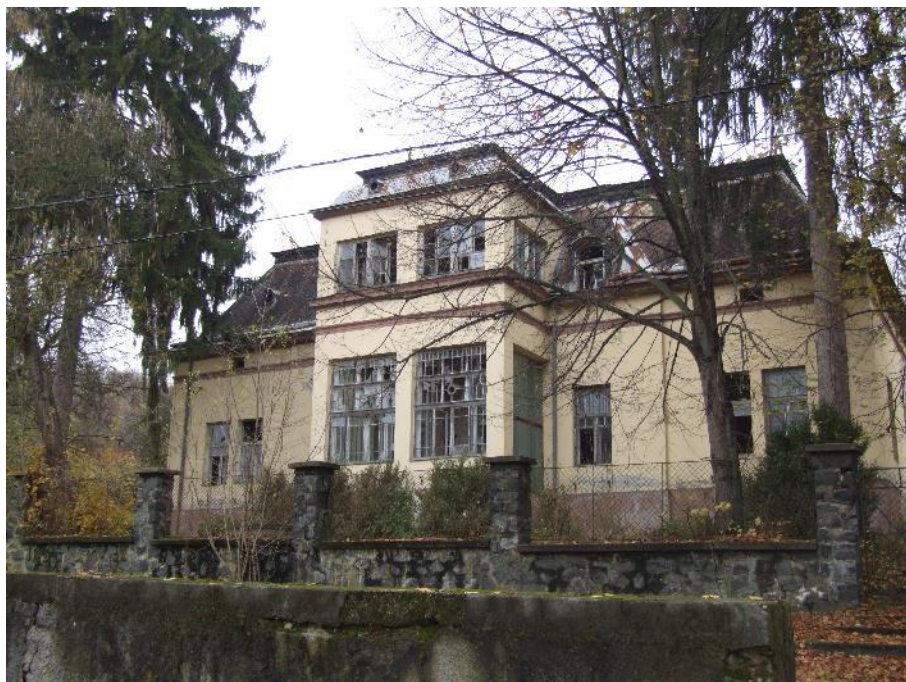
Kőszénbánya igazgatói lak (veszélyeztetett) (Településképileg meghatározó)
